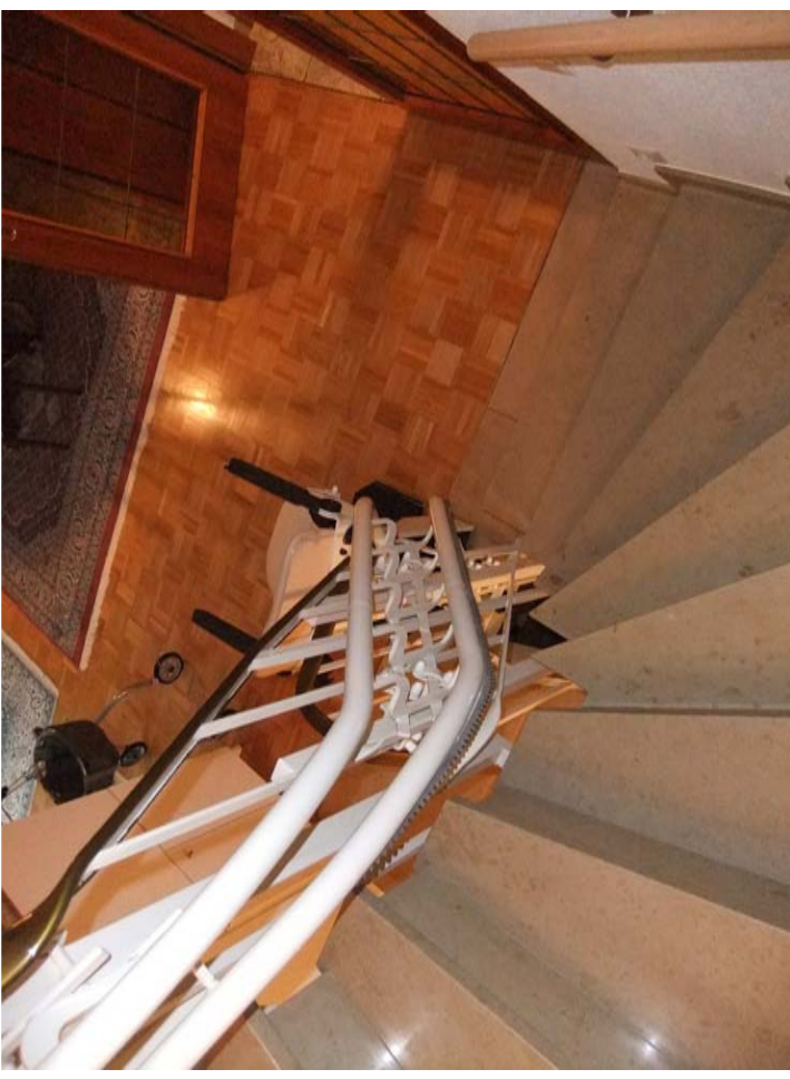
KIRCHNER TREPPENLIFT, z.B. Montage nicht auf den Stufen, sondern an der Innenseite der Treppenwange
