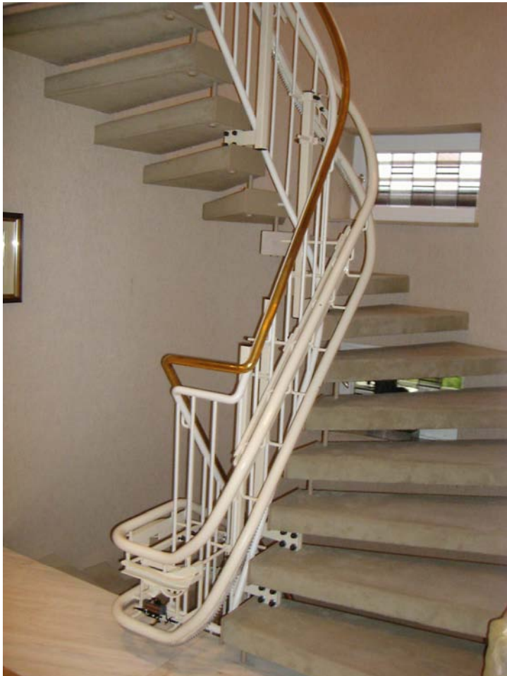
Bei dieser freitragenden Treppe werden die Fahrbahnstützen an die Abstandshalter der Stufen geklammert. Vorteil: Die Stufen werden nicht beschädigt durch die Montage der Fahrbahnstützen!
