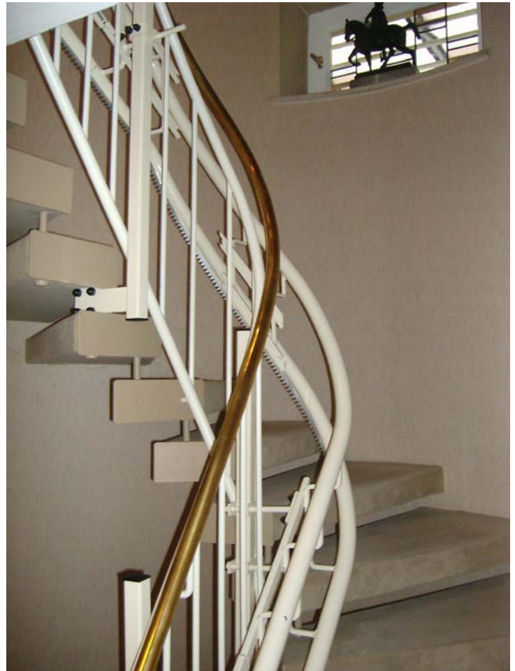
Bei dieser freitragenden Treppe werden die Fahrbahnstützen an die Abstandshalter der Stufen geklammert. Vorteil: Die Stufen werden nicht beschädigt durch die Montage der Fahrbahnstützen!
