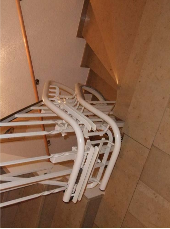
KIRCHNER TREPPENLIFT, z.B. Montage nicht auf den Stufen, sondern an der Innenseite der Treppenwange
